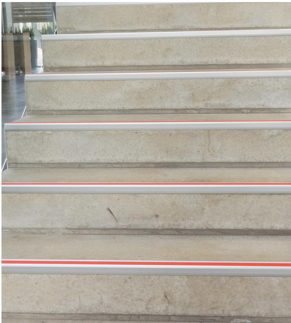
Treppen und Stufen sind insbesondere für blinde und sehbehinderte Menschen eine besondere Herausforderung. Ein wichtiges Element eines barrierefreien Leit- und Orientierungssystems sind daher kontrastreiche Stufenmarkierungen, die sich optisch und haptisch von den Treppenstufen unterscheiden und eindeutig abheben. Consystec bietet rutschfeste und aufmerksamkeitsstarke Markierungen aus Kunststoff oder Aluminium an, die für innen und außen geeignet sind.
